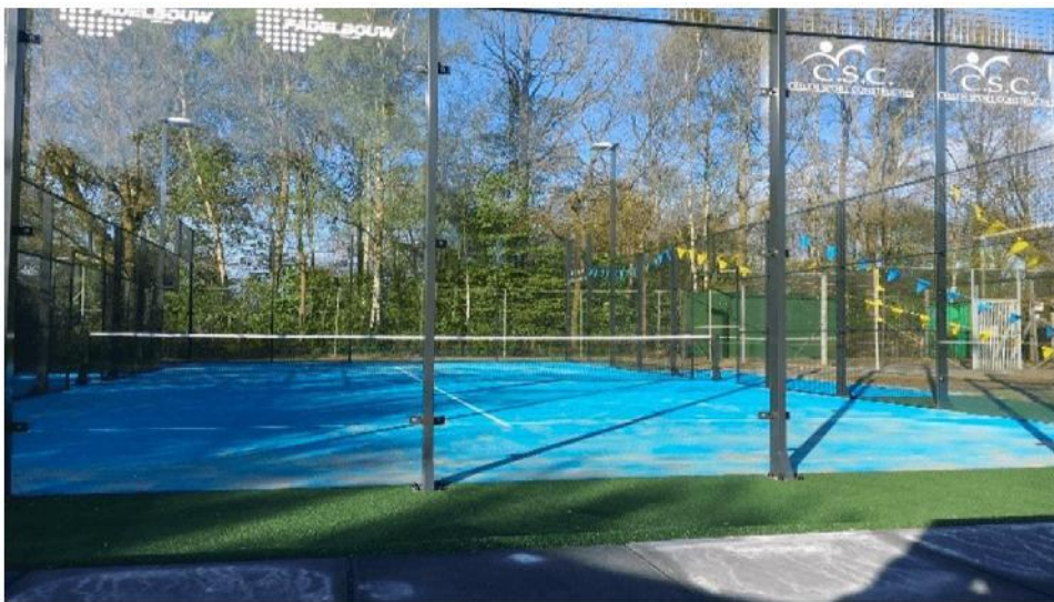
Figuur 3: foto-impressie van een pilaar systeem kooi (op voorgrond zijn slechts 3 van de 5 glazen platen zichtbaar)
